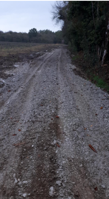
remise en état chemin
